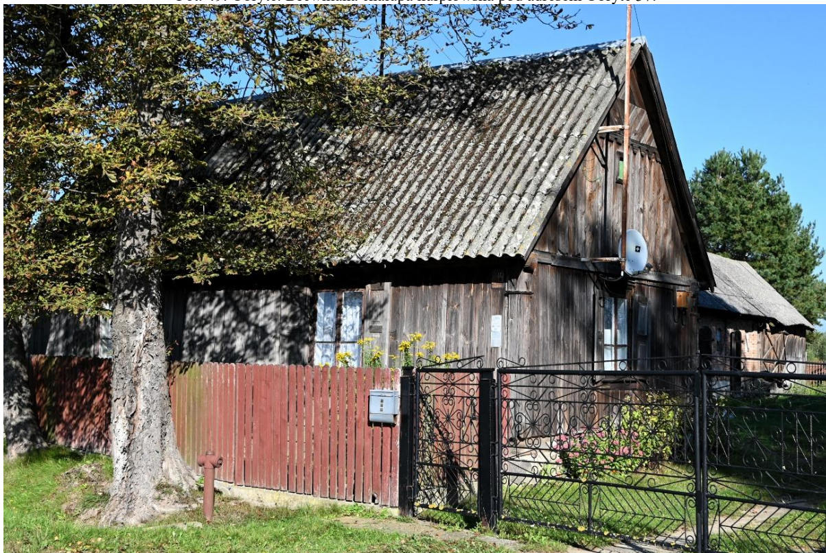
Fot. 50. Gładczyn Szlachecki. Drewniany dom mieszkalny nr 19.
