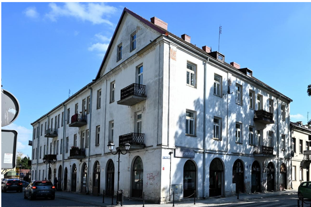
Fot. 6. Pułtusk. Zabudowa mieszkalna u zbiegu ulic Piotra Skargi i Benedyktynskiej.
